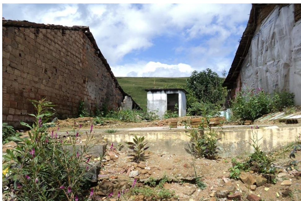
Figura 16 - Uma das muitas residências que tiveram que ser demolidas. Fonte: Acervo dos autores, 2010.
