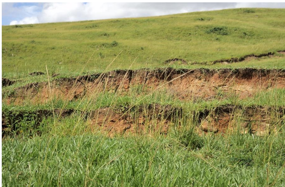
Figura 8 - Fissuras transversais e radiais. Fonte: Acervo dos autores, 2010.
