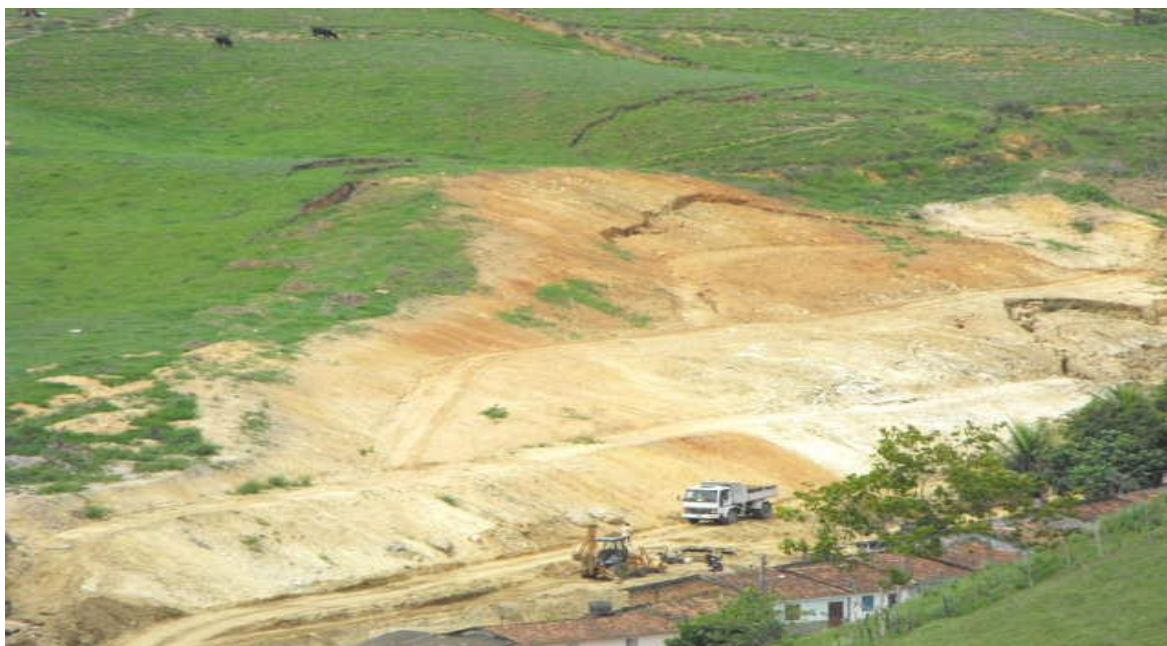
Figura 3 – Máquinas realizando escavações durante obras na ferrovia. Fonte: Anjos, 2010.
