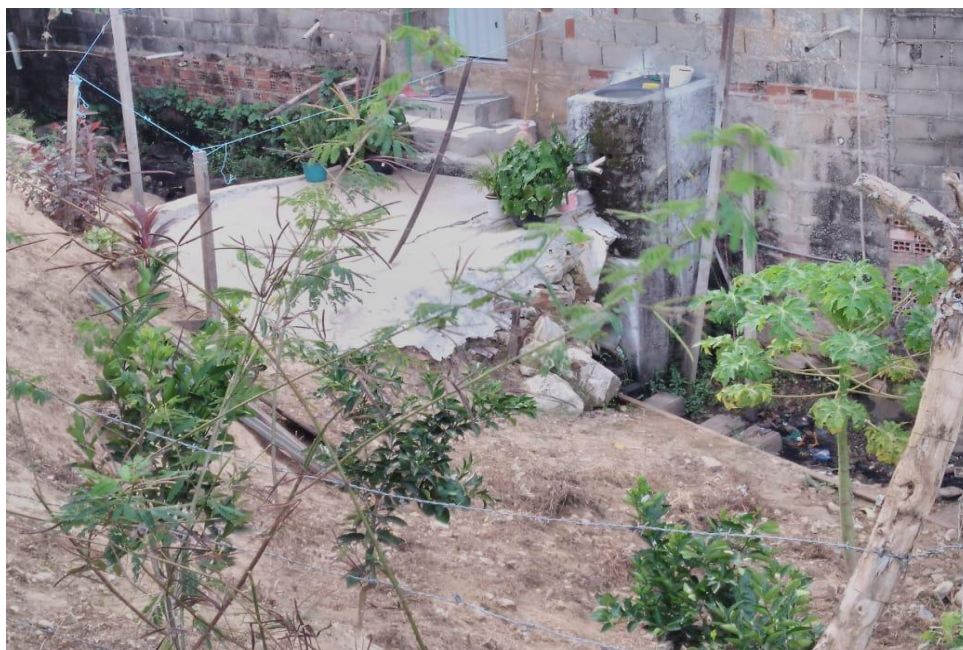
Figura 21 – Linha férrea e material alóctone da encosta sendo aproveitados por moradores de outra rua (rua Dourada), sem sinais de instabilidade. Fonte: Acervo dos autores, 2020.
